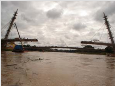
Passarela Estaiada com 200 m Rio Acre – Rio Branco, AC – em montagem
