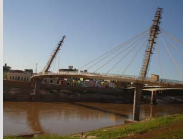
Passarela Estaiada com 200 m Rio Acre – Rio Branco, AC – fase final
